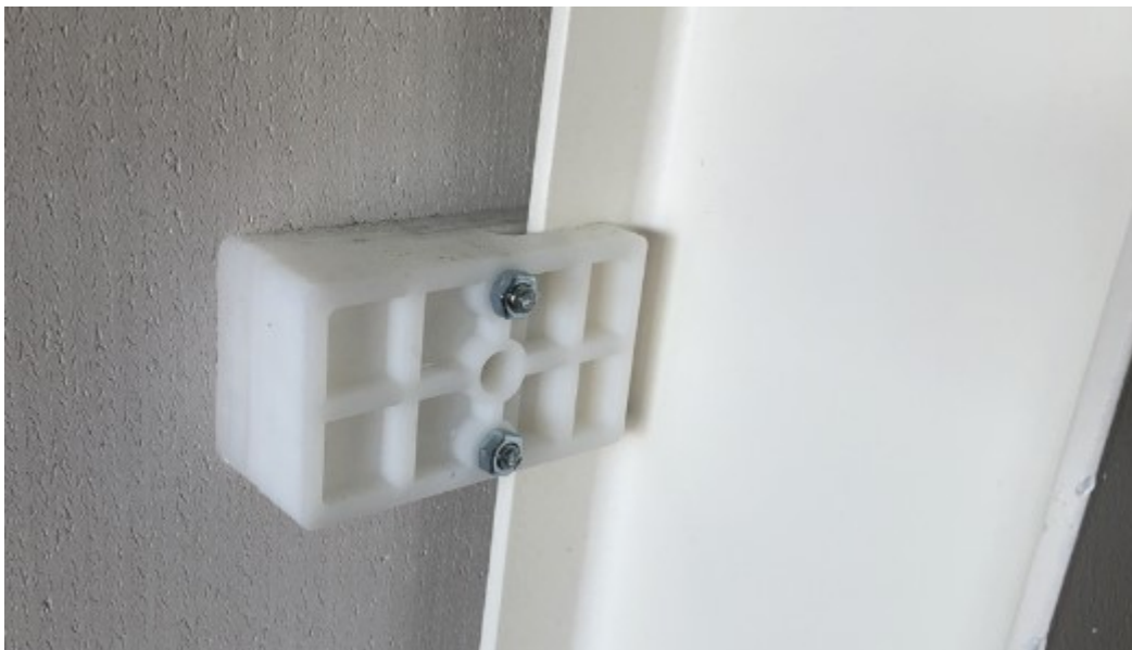
Photo n°02 – Exemple de crapautage fusible à prévoir
