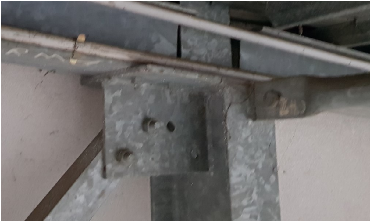
Photo n°05 – Diamètre des boulons différent – Palée de stabilité file 8
