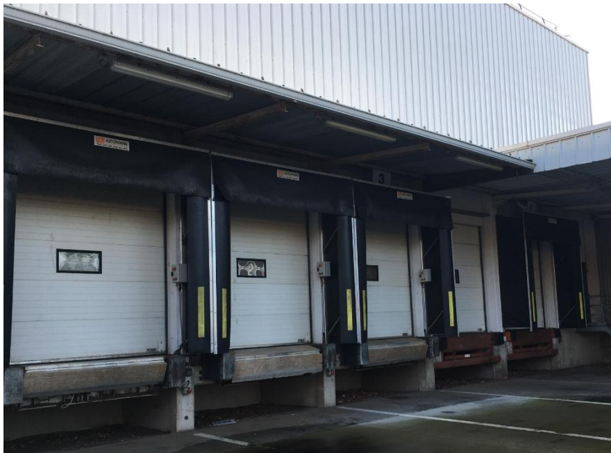
Présence de auvents au-dessus des quais
